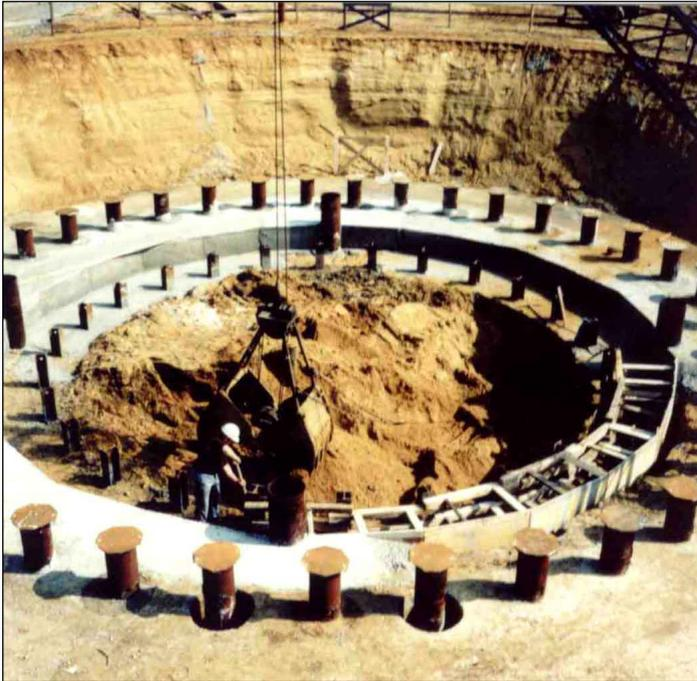
*Kranz der Gefrierbohrlöcher für Schacht Haltern 1 (Foto:Malgut)*
