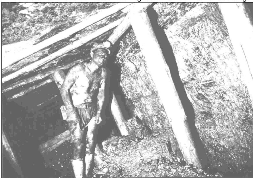
Schwebender Verhieb in Flöz Karl 2 ( Abbauhammerstreb )
